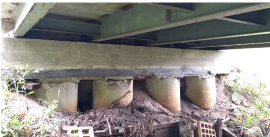
Posadowienie mostu na studniach betonowych
