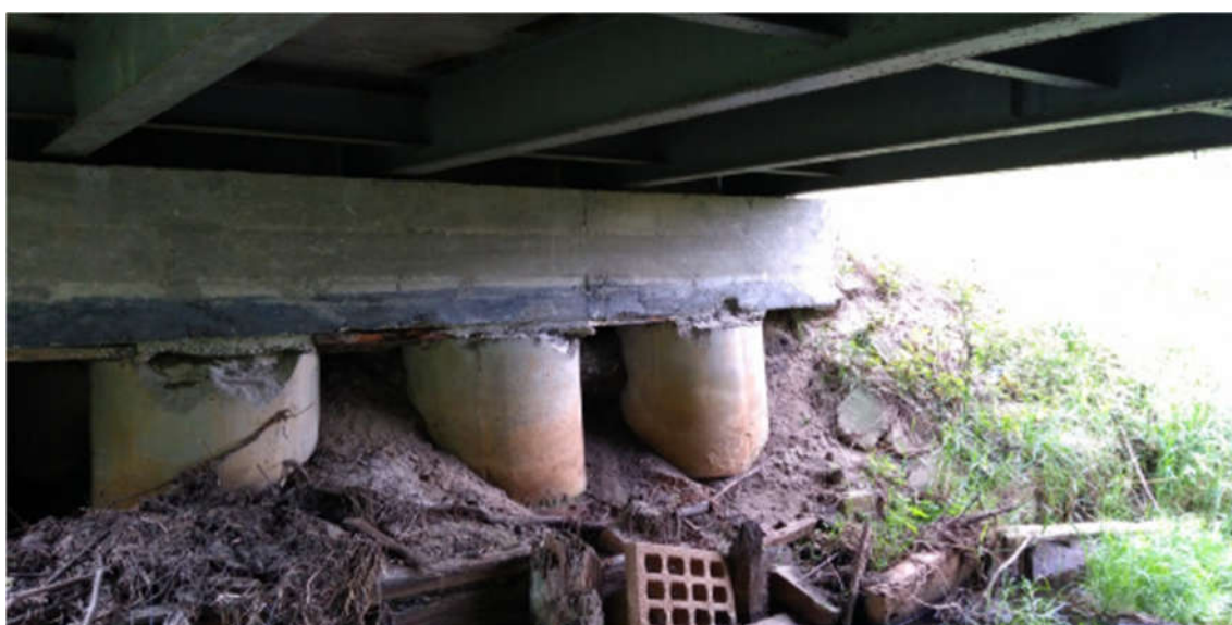
Jak wyżej – degradacja studni fundamentowych
